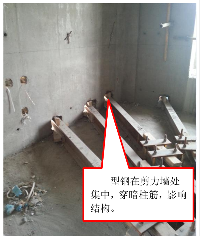
型钢在结构边缘未锚固，尾部锚固处未使用木方塞紧。
