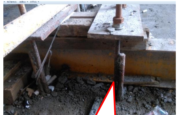
锚固筋不宜接长，焊接不规范。两侧未用木方塞紧。
